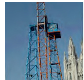
Parkhäuser Zuverlässige Steuerung schwieriger Lasten in Spanien
